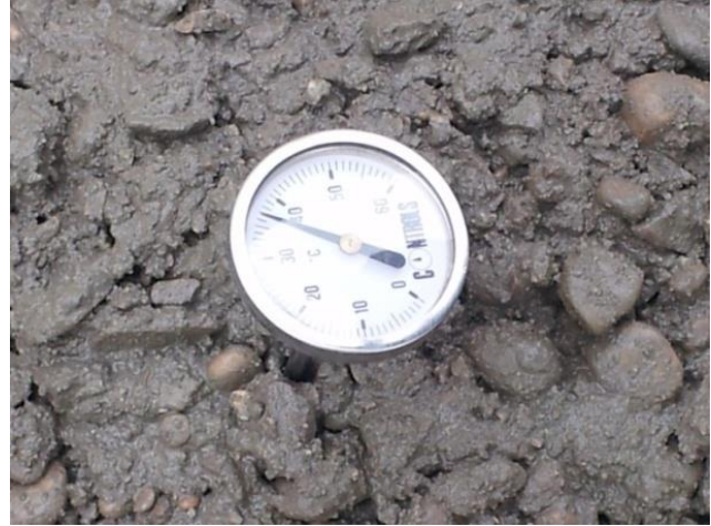
Imagen 3. Control de temperatura del hormigón
