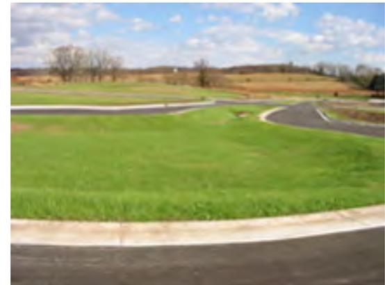
Depósito de infiltración en zona vial. Fuente: Northeast Wisconsin Stormwater Consortium
