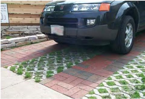
Pavimento permeable en Ipswich (UK). Fuente: Susdrain
