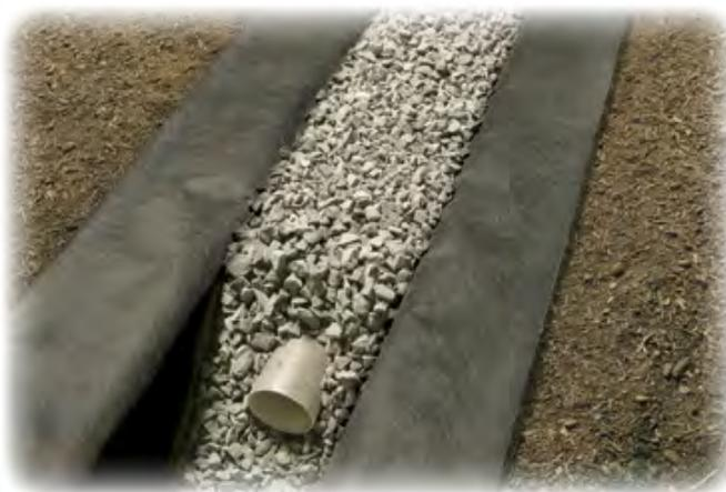
Estas zanjas, donde no está presente la vegetación, están concebidas para captar y filtrar la escorrentía de superficies impermeables contiguas con el fin de transportarlas aguas abajo. Además pueden permitir la infiltración y la laminación de los volúmenes de escorrentía.
