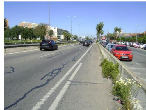
Grietas longitudinales reparadas a la altura del PK 2+400. A la derecha se aprecia el ramal que luego se incorpora
