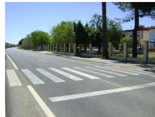
Inicio del tramo en PK 3+350
