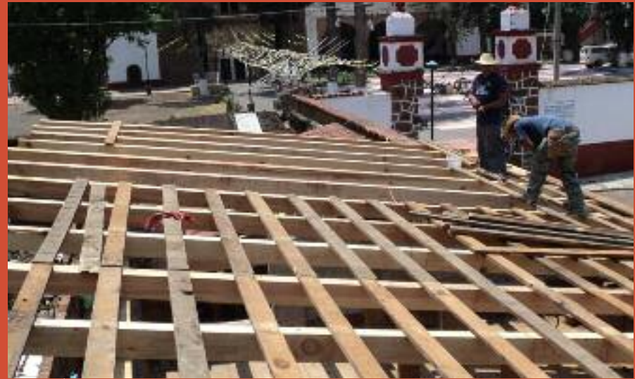
ERONGARICARO: Casa de Susana Solorio en restauración. Abajo a la derecha aparecen su fachada y techo restaurados.
