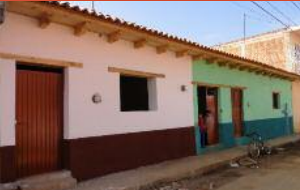
ERONGARICARO: Casa de la familia Zira Aparicio antes y después de las obras.
