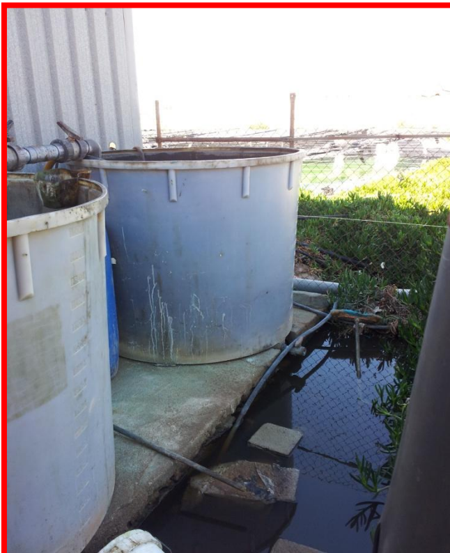
Depósito sin tapa y situado en el exterior y sin protección.
