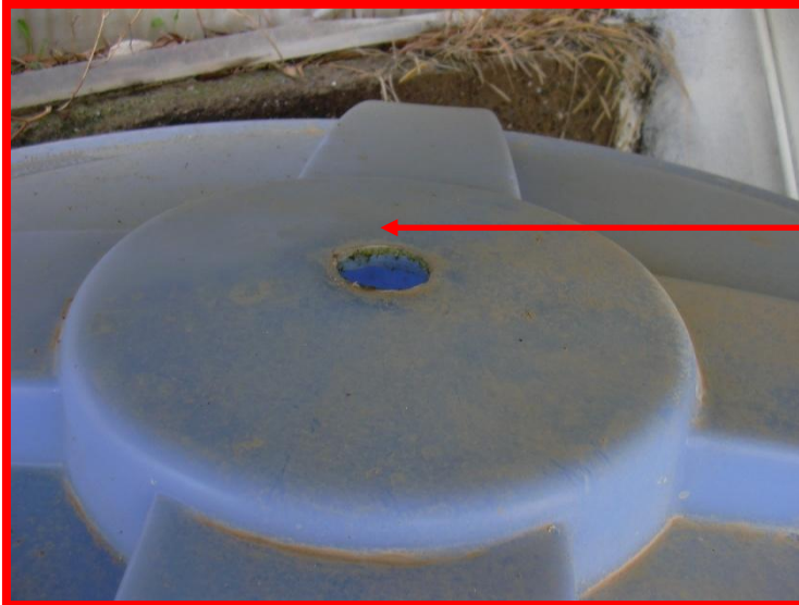
Dispositivo compensador de presiones deficiente.
