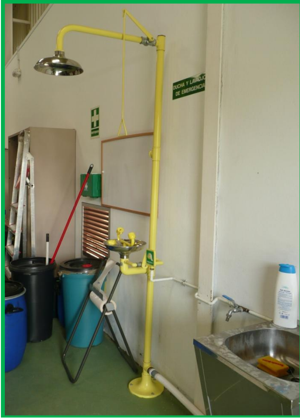
Ducha y lavabo de emergencia ante posibles accidentes.
