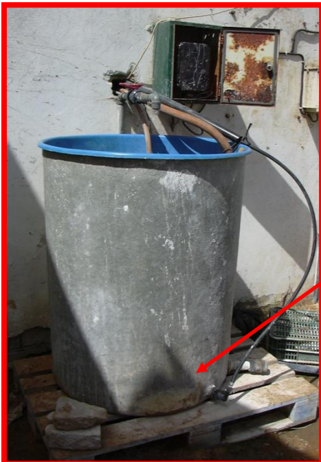
Depósitos con manchas de humedad relacionadas con fugas.
