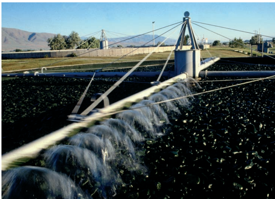
Planta de tratamiento de aguas residuales industriales
