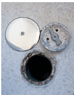
10. BOTE SIFÓNICO CON TAPA DESMONTADA.
