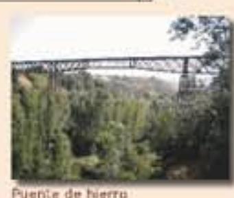
Puente de hierro
