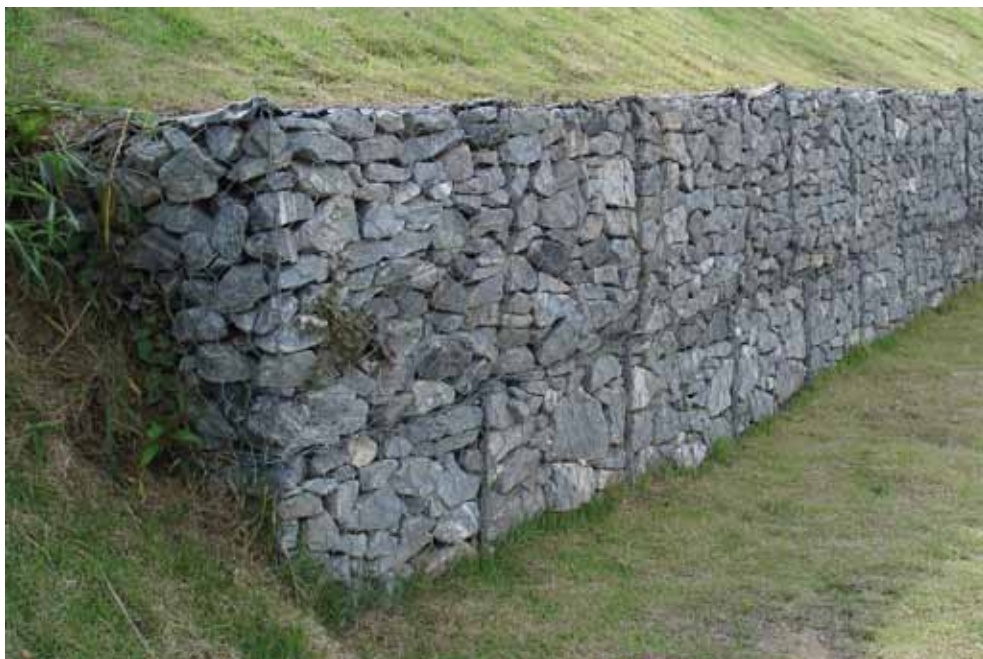
Figura 30. Muro de contención de mampostería. Cortesía de Eurico Zimbres.
