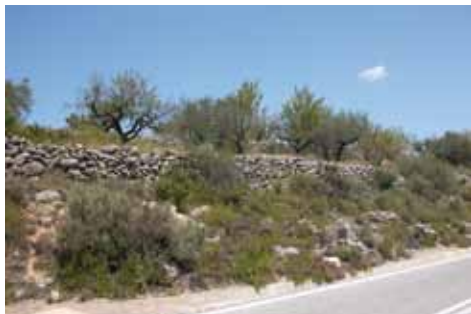
Figura 28. Muro de contención de piedra.
