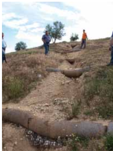
Figura 22. Pequeños diques de contención construidos con gaviones flexibles de biorrollos.
