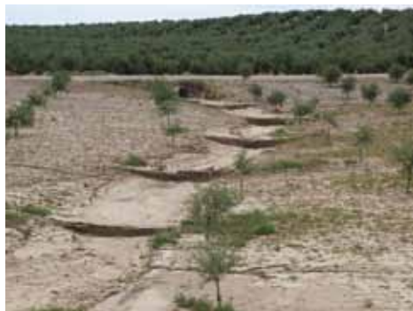
Figura 7. Vista de varios diques de retención espaciados.
