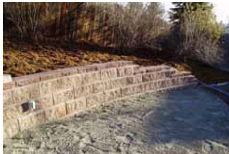
Figura 29. Muro de contención de mampostería. Cortesía de AS Concrete.
