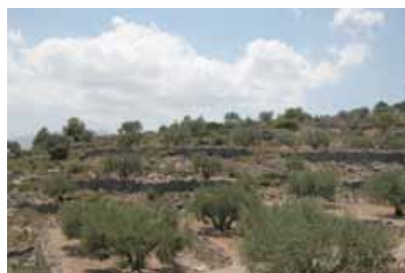
Figura 27. Foto de muros de contención de piedra.
