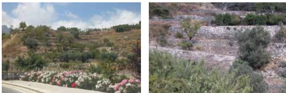
Figura 25. Vista general y de detalle de muros de contención.
