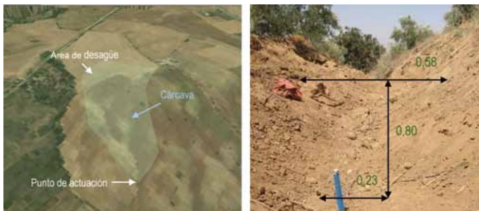
Figura 23. Vista del rea del desagüe que vierte al punto de actuacin (izquierda) e imagen y dimensiones de la seccin transversal de la cárcava en dicho punto (derecha).
