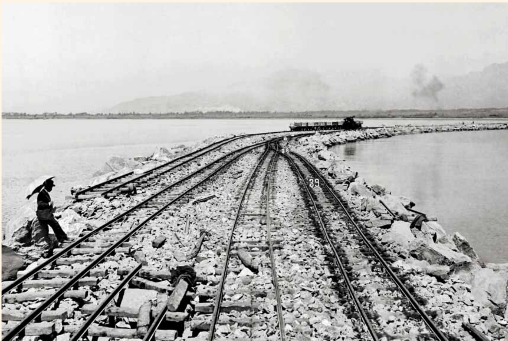
Vías del tren del espigón, que se utilizaba para el transporte de materiales en la construcción del puerto Año 1911
