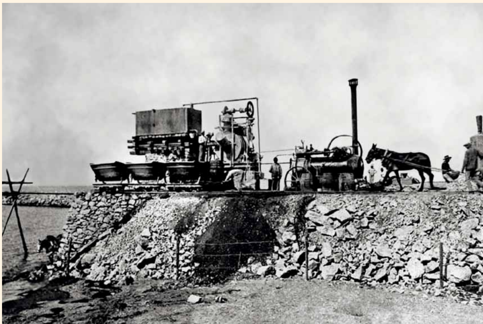
Maquinaria a vapor que se usaba para mezclar las piedras menudas que componen el hormigón Año 1913
