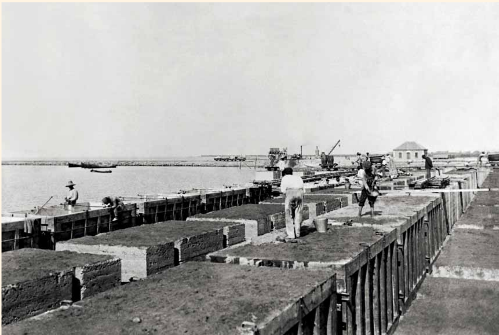
Instantánea que muestra el trabajo de los encofradores en el “taller de bloques” para la construcción del puerto Año 1913
