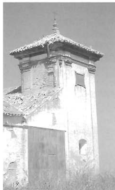
▲ Torre contrapeso de la almazara de Aguilar, Ecija, 1777.
