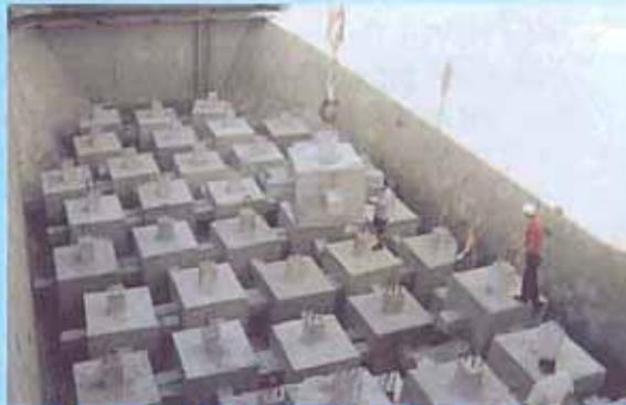
▲ Carga de módulos arrecifales al barco instalador
