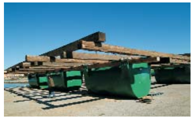
Detalle de flotadores de chapa de hierro marino recubiertos de poliéster.
