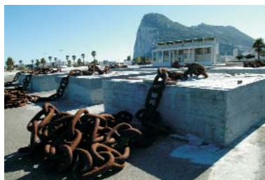
Detalle del sistema de fondeo de las bateas: cadena, bloque de hormigón o "muerto".
