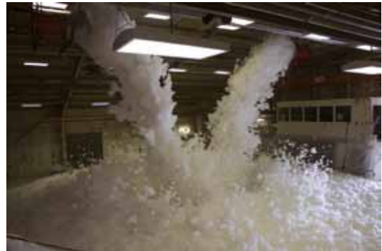
Figura 54. Compartimentos inundados con espuma de alta expansión
