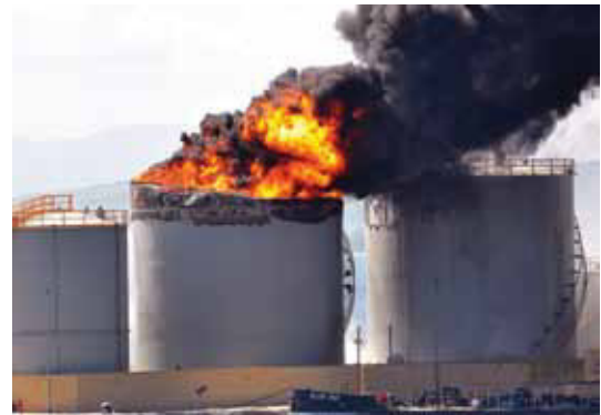
Figura 5. Incendio/explosión por electricidad estática
