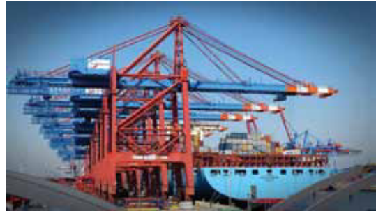
Figura 23. Gruas de carga y descarga
