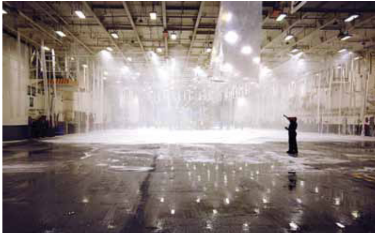
Figura 62. Sistema de tubería mojada
