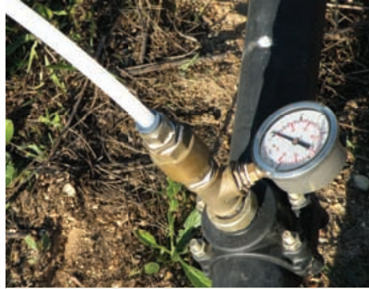
Figura 4. Collarín de toma para conectar con la tubería de riego
