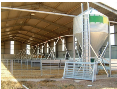
Silos de pienso con línea de transportador.
