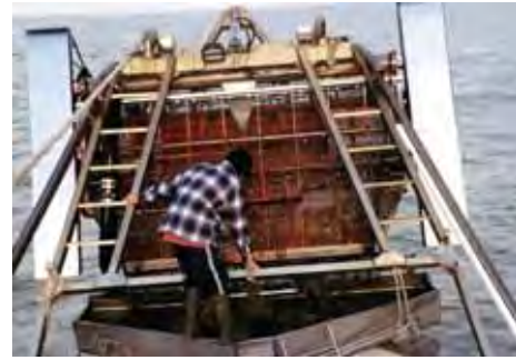
Figura 29. Parrilla de Dragas Hidráulica
