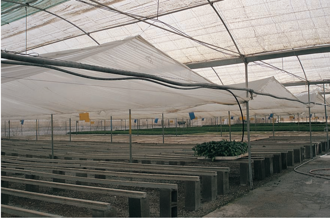
Foto 7. Colocación de un doble techo
