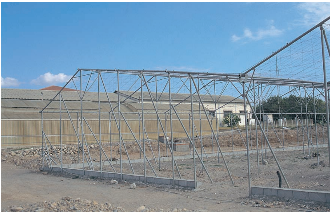
Foto 12. Estructura metálica de un invernadero de cubierta inclunada asimétrica
