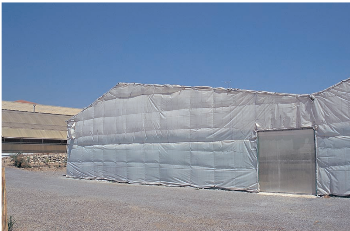
Foto 5. Invernadero de cubierta inclinada asimétrica
