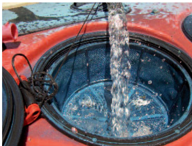
Figura 13. Llenado de depósito y filtro principal en buen estado
