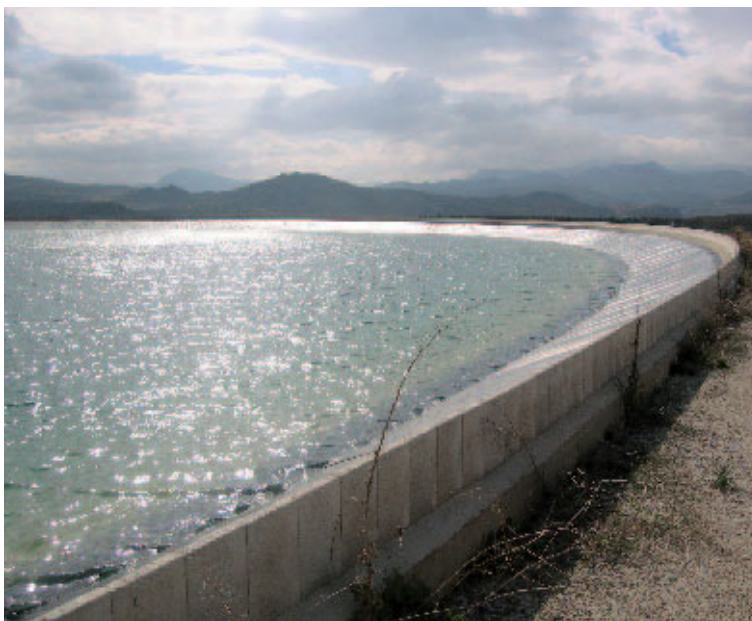
Figura 2. Balsa de almacenamiento de aguas invernales para el riego de olivar.
