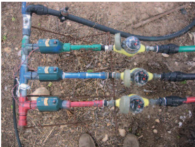
Figura 7. En P.I. es obligatorio disponer de sistemas de medición del consumo del agua
