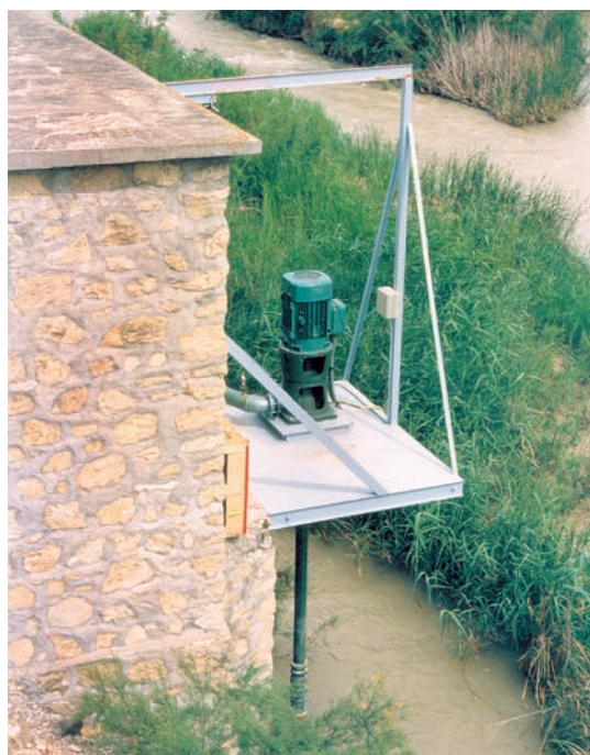
Figura 9. Grupo electrobomba de eje vertical. Puede observarse el motor situado fuera del agua y el eje de impulsión.
