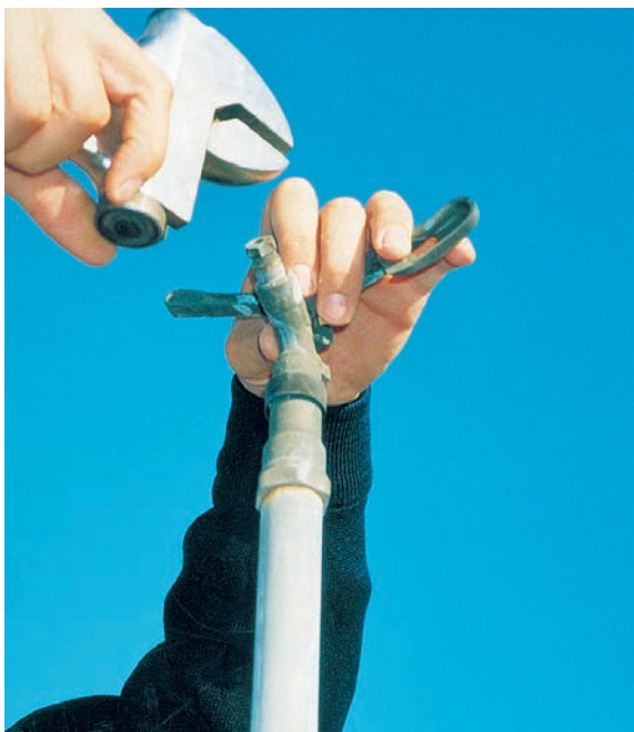
Figura 1. Operación de cambio de una boquilla defectuosa del aspersor.
