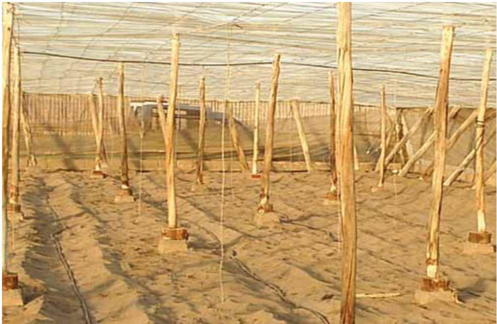
Fig. 1. Invernadero plano tipo parral de estructura de palo
