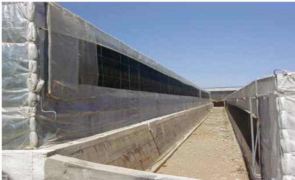
Fig. 11. Ventilación lateral en dos invernaderos planos
