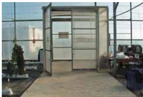
Fig. 1. Doble puerta en invernadero para evitar la entrada de insectos
