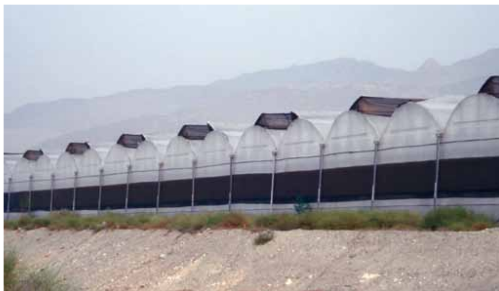
Fig. 4. Invernaderos de P.V.C. rígido formado por naves adosadas y con ventilación cenital
