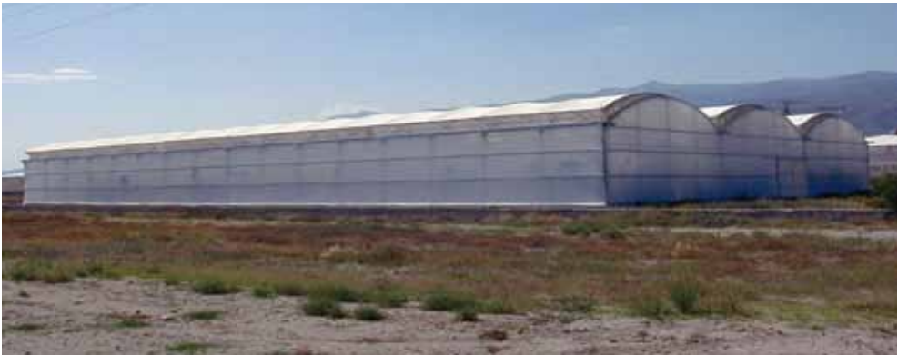
Fig. 5. Batería de invernaderos tipo túnel
