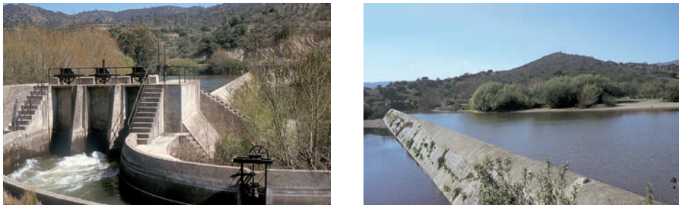
Figura 5. Obras de infraestructura destinadas a suministro de agua para riego
