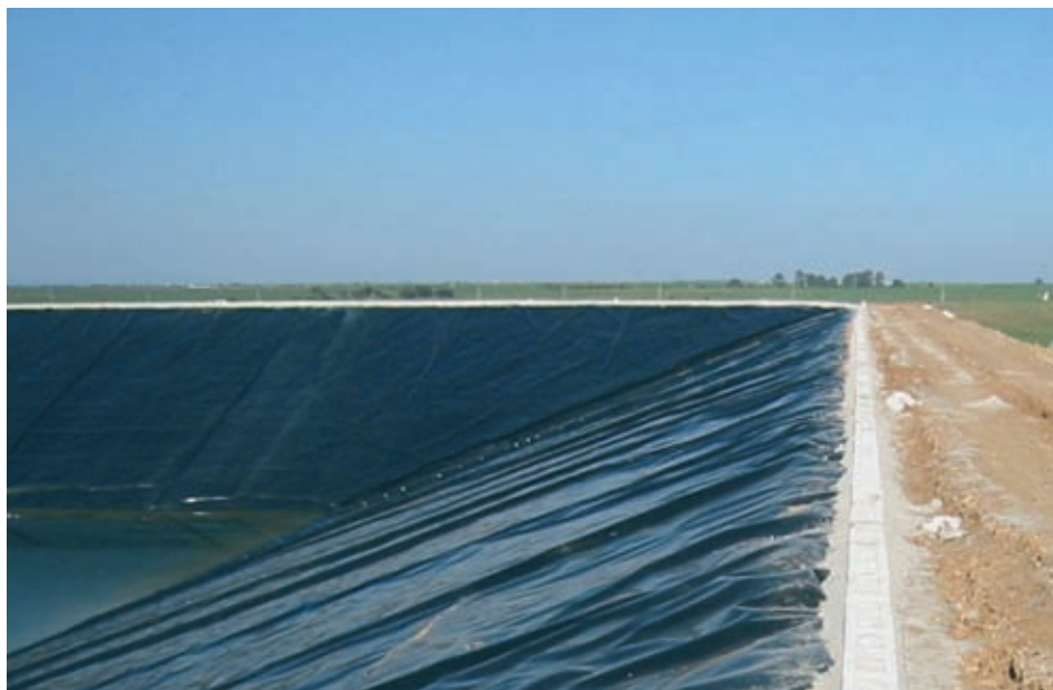
Figura 2.7.6. Colocación de pretil en coronación
