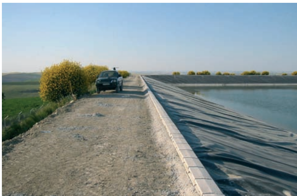
Figura 2.7.7. Terminación con pretil en coronación
