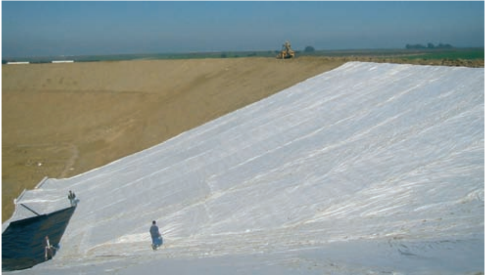
Figura 2.7.3. Colocación de geotextil en talud interior
