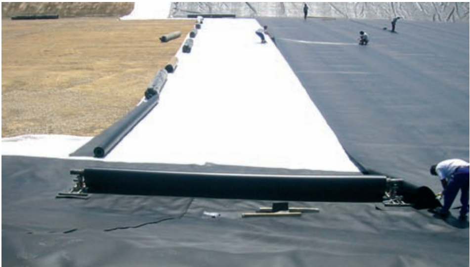
Figura 2.7.4. Colocación de la geomembrana sobre el geotextil
