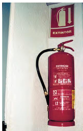
Figura 5. Extintor contra incendios en el local de almacenamiento de fitosanitarios
