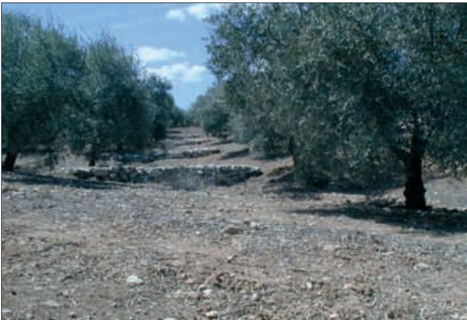
Figura 3. La construcción de diques en zonas de vaguada puede reducir la velocidad del flujo de agua. Nueva Carteya (Córdoba).
