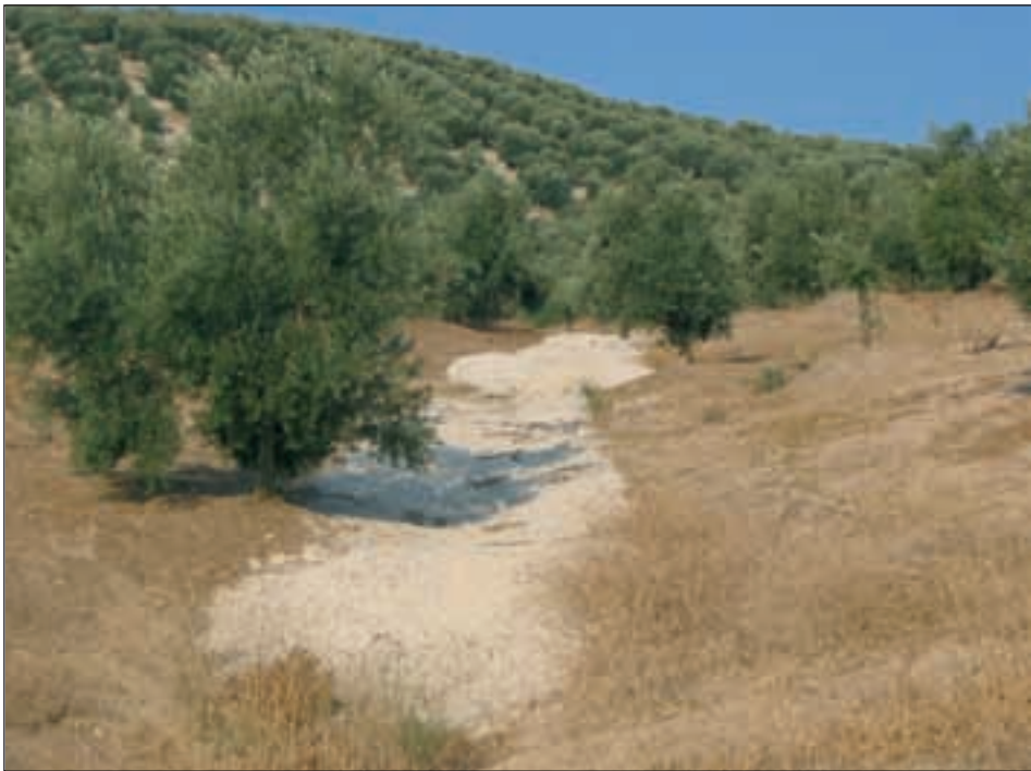
Figura 2. Adición de hormigón para frenar la evolución de una cárcava. Nueva Carteya (Córdoba)
