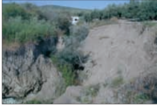
Figura 6. A veces la situación es irremediable. La construcción de obras de paso que recogen elevados volúmenes de agua de escorrentía por manejos inadecuados aguas arriba puede generar situaciones como la expuesta. Pérdida de olivo. Baena (Córdoba).
