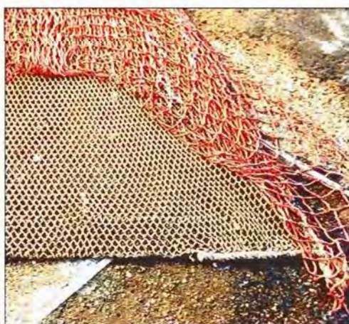
Fot. 37 - Refuerzo o chaleco.
