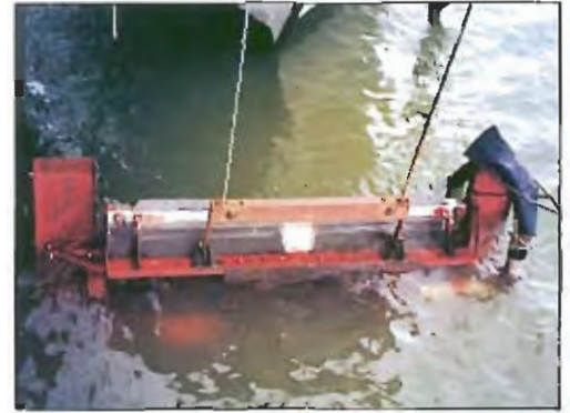
Fot. 73 - Cabos o tiros de la parrilla.
