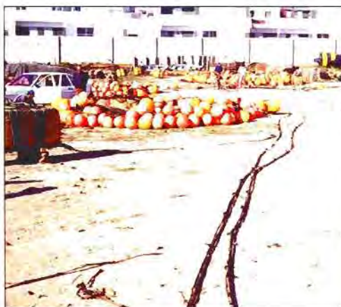
Fot. 10 - Cables alquitranados del armado superior.
