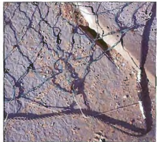
Fot. 27 - Refuerzo de las mallas de la armadura.
