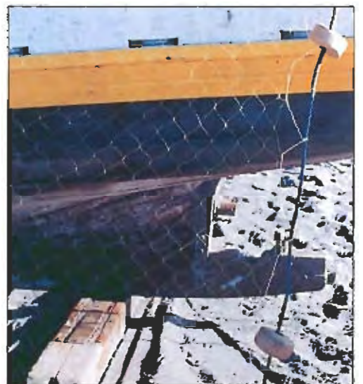
Fot. 57 - Reliuga de flotadores y armado.
