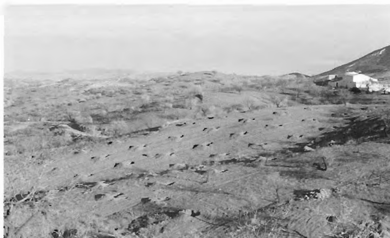
Plantación mediante apertura de hoyos con retroexcavadoras.
