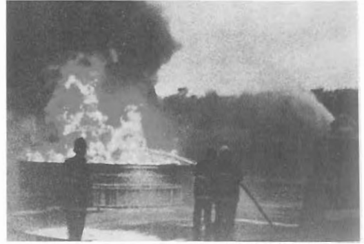
La espuma química es un excelente agente extintor para fuegos producido por combustibles.
