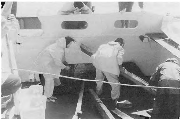
Apuntalamiento sobre mamparo vertical
