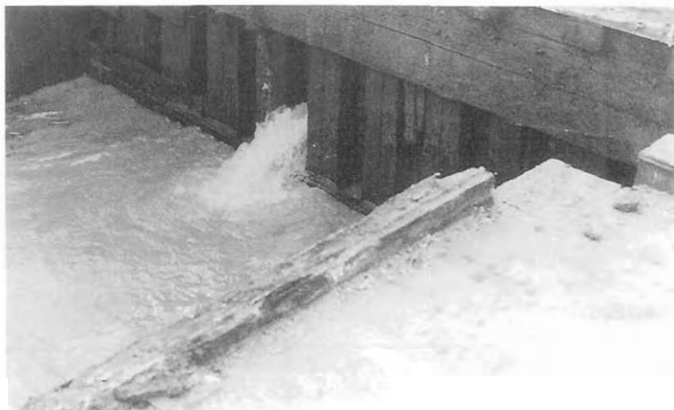
Vía de agua
