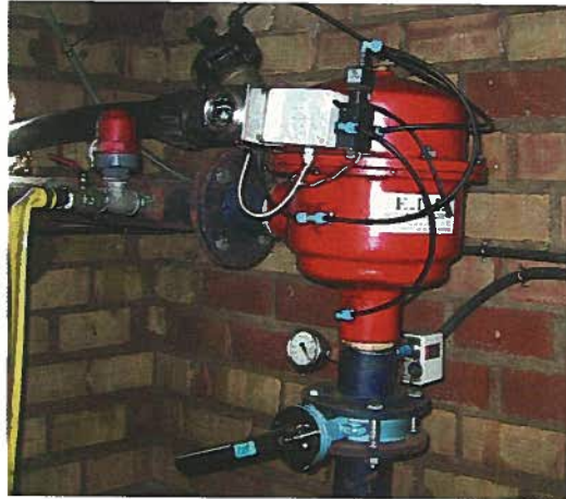
Foto 5.2 Filtro automático de mallas que proporciona muy buenos resultados en las modernas instalaciones.
