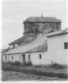
Torre contrapeso del molino de Pedro Abad, Córdoba.
