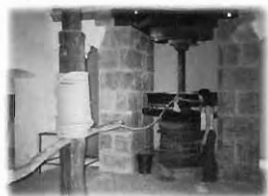
Donpedro o palopedro y mecanismo de la prensa de torre. ▲
