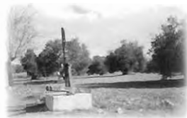
La cruz deteriorada.
