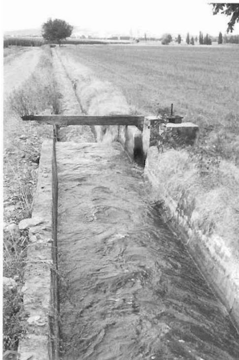
Figura 5. El agua suele llegar a la parcela mediante un sistema de distribución formado por canales o acequias.
