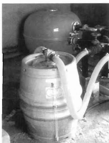
Figura 3. Tanque de fertilización.
