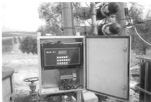
Figura 15. Programador de riego.
