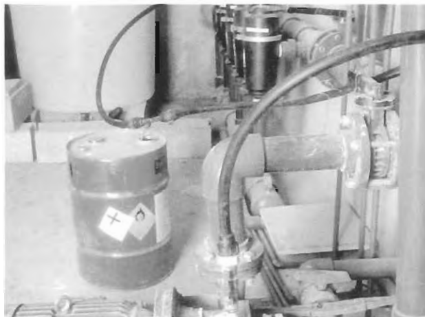
Figura 2. Aplicación de productos fitosanitarios a través de la instalación de riego localizado, haciendo uso de un inyector Venturi.
