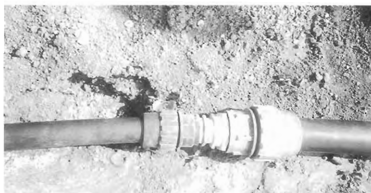
Figura 18. Cambio de diámetro en una tubería de polietileno utilizando racores de unión.
