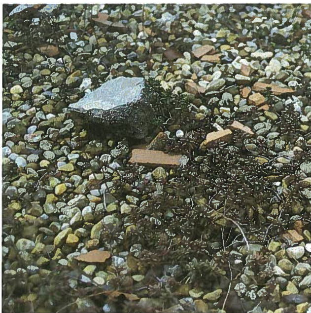
Foto tomada en la cubierta de la Casa de Brasil, Madrid, donde el Sedum sobrevive desde hace muchos años.
