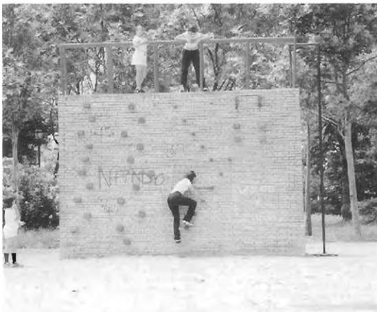
Muro de escalada con altura de caída libre superior a los 3.00 mts y sin protección lateral
