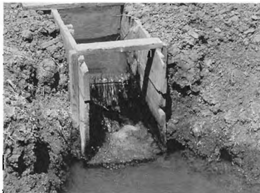
Foto 1: Detalle de una "caja de desagüe" o "piquera" de un arrozal.
