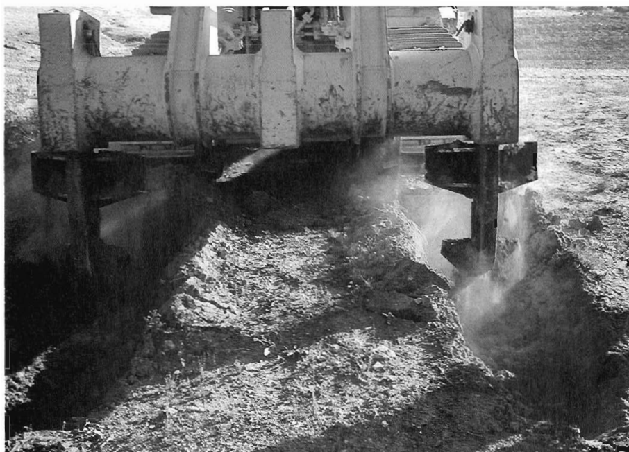
Foto 5. Ahoyado con buldozer (Laura Álvarez Linarejos).
