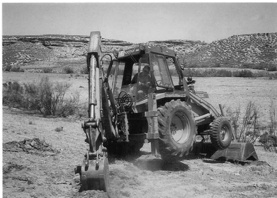
Foto 4. Retroescavadora (Laura Álvarez Linarejos)
