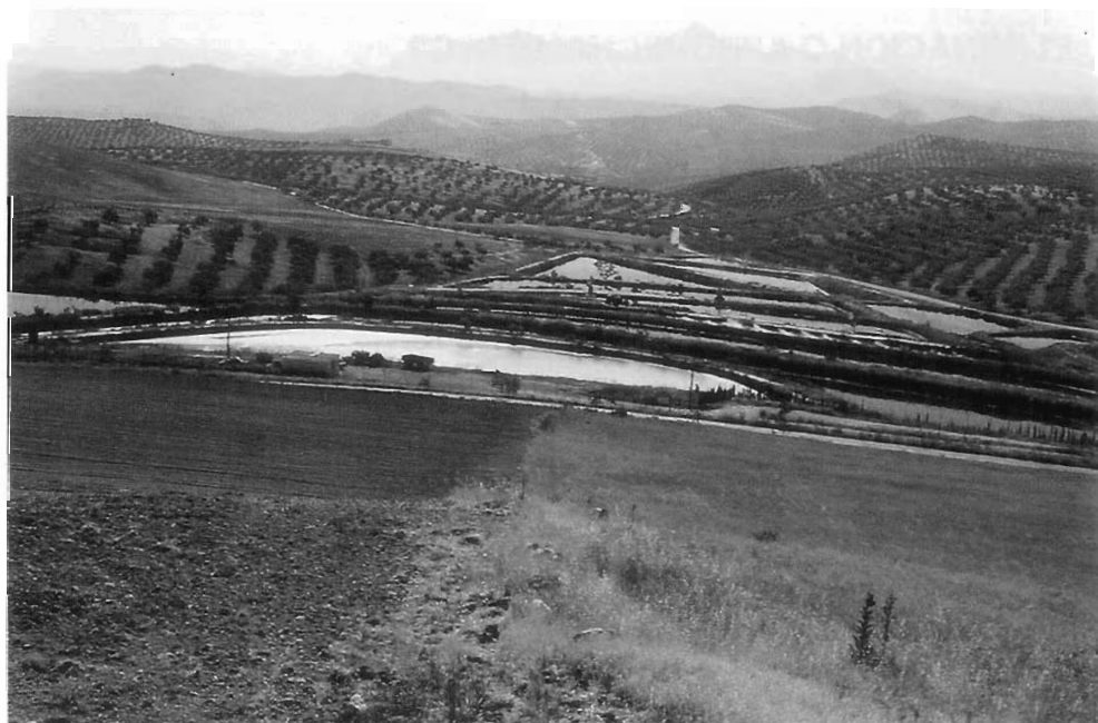
Las balsas de evaporación, visibles en las áreas olivareras, no suponen soluciones anti-contaminantes a los vertidos y excedentes de alpechín.
