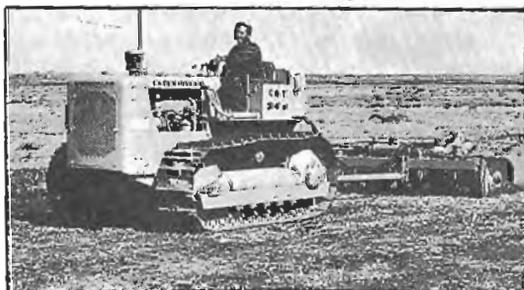
Fig. 326.- Tractor de cadenas u orugas (CATERPILLAR)
