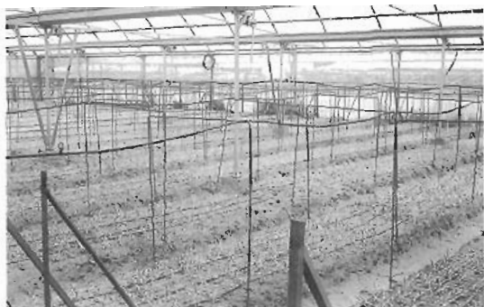
Foto 19: Instalación móvil de riego por microaspersión.
