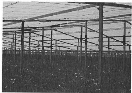
Foto 5: Interior de invernadero con estructura de hormigón.
