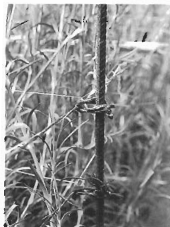
Foto 16: Detalle de atado de la malla al arquiño o cabilla.
