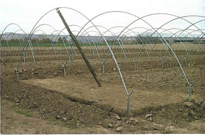
▲ Fig. 12 - Estructura de invernadero túnel de 6,5 metros de ancho. Observese el puntal de rollizo que contrarresta la acción del viento. Los arcos van unidos por cumbre por medio de un alambre galvanizado grueso o un cable de acero.
