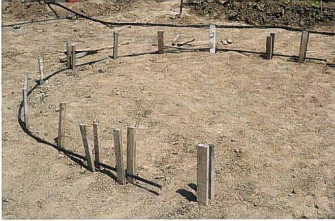
▲ Fig. 26 - Escantillón para dar forma de arco, en el mismo campo donde se van a instalar los macro-túneles.
