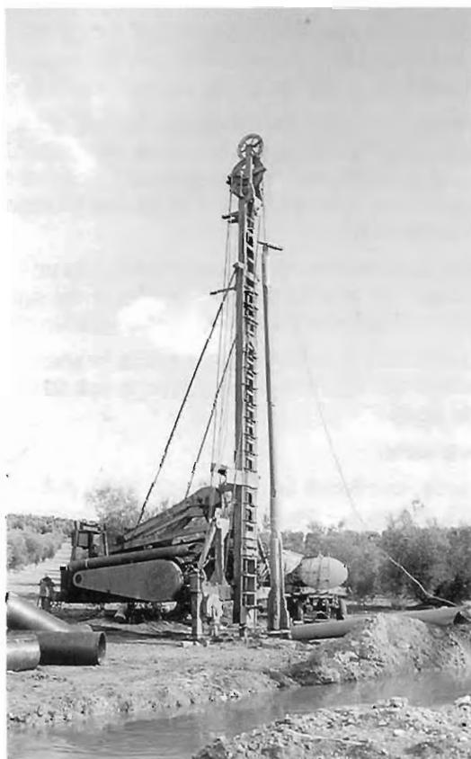
**Fotografía 1:** Después de varios años de sequía muchos olivereros han buscado en las aguas subterráneas la posibilidad de obtener los caudales suficientes para el riego de su olivar. En la fotografía máquina de percusión perforando un pozo profundo en un olivar de la provincia de Jaén. No siempre se están ejecutando correctamente estas obras de captación.
