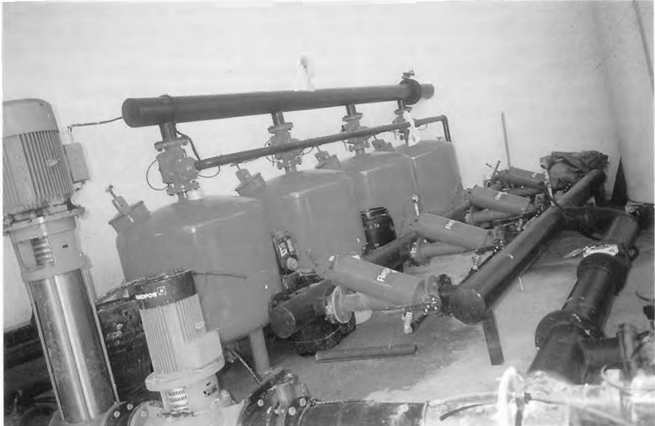
**Fotografía 5:** Estación de filtrado de una moderna instalación de riego por goteo en la localidad de Canena en Jaén. La instalación cuenta con filtros de arena, filtros de malla, y posibilita igualmente la fertirrigación, a través de la propia instalación de riego por goteo.
