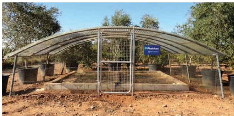
Figura 3. Sistema Phytobac con acceso protegido
