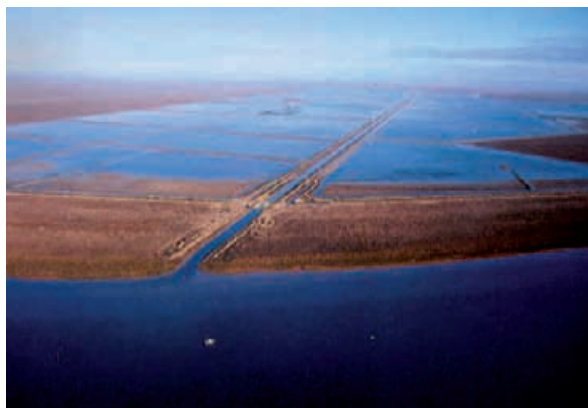
Fotografía 2 - 2 Vista aérea de instalaciones en Sevilla.
