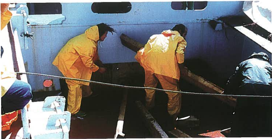
Apuntalamiento sobre mamparo vertical
