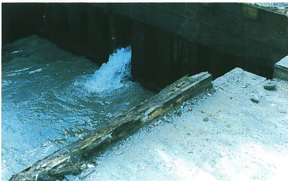
Vía de agua.
