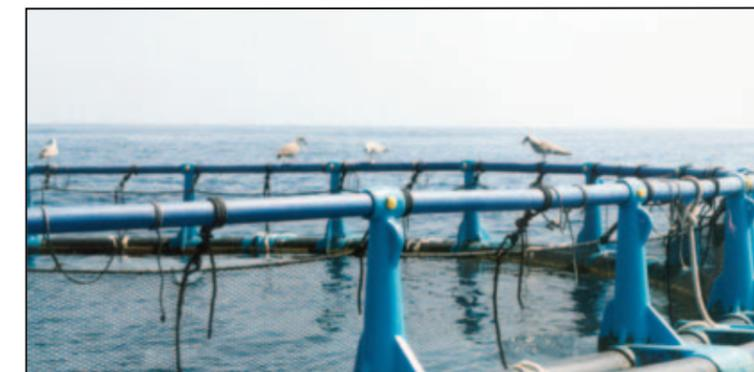
Foto 4: Detalle de instalación de acuicultura marina en jaulas flotantes.
