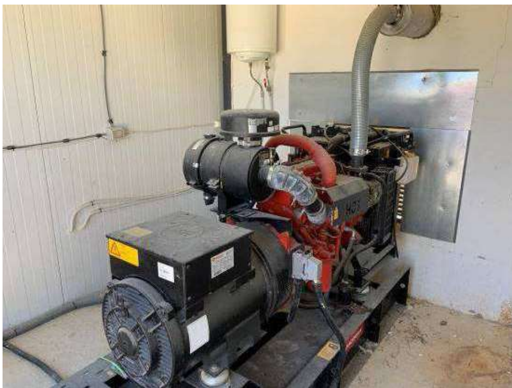
Grupo electrógeno para suministro de emergencia en caso de fallo en el suministro eléctrico.
