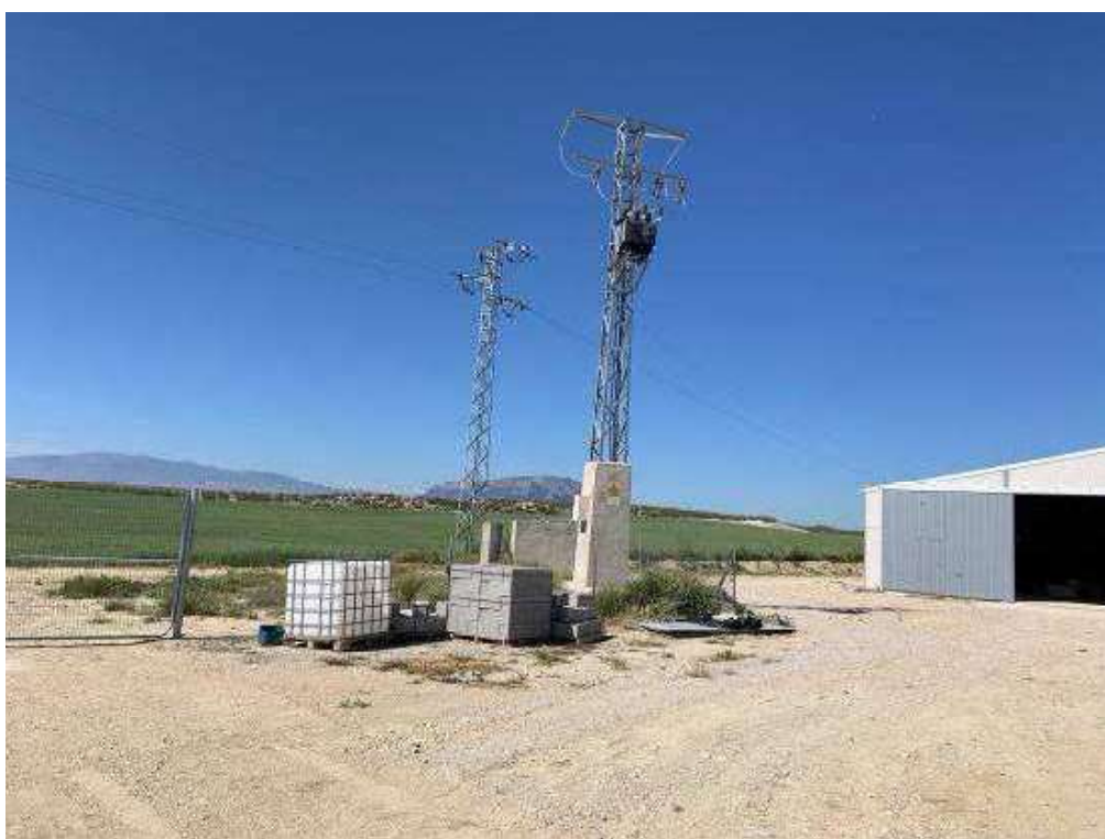
Centro de transformación intermedia que alimenta de electricidad a la explotación
