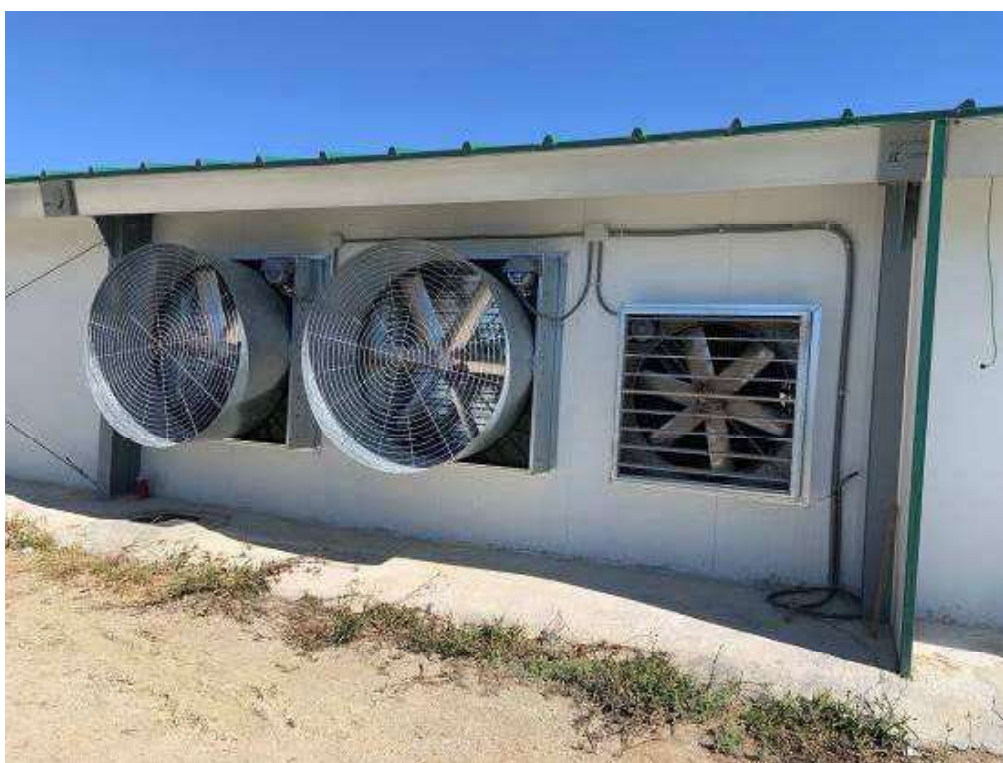
Vista de sistema de ventilación que existen en cada extremo de nave
