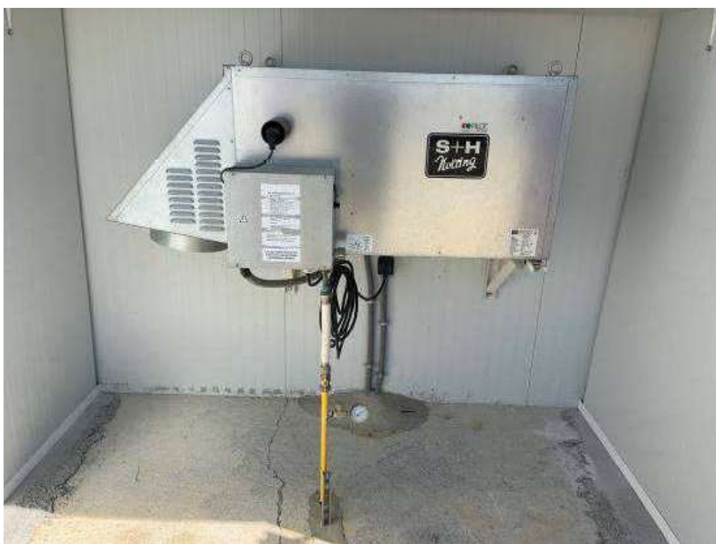
Calefactor de gas propano (dos instalados por nave)
