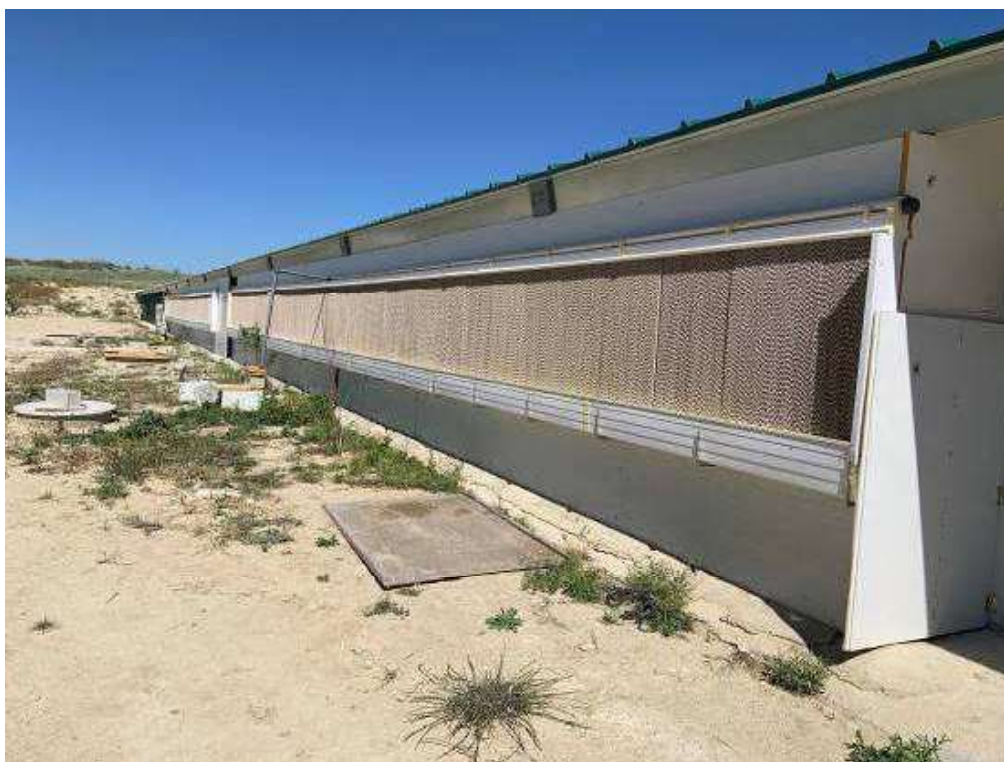
Vista de humidificadores instalados en cada nave
