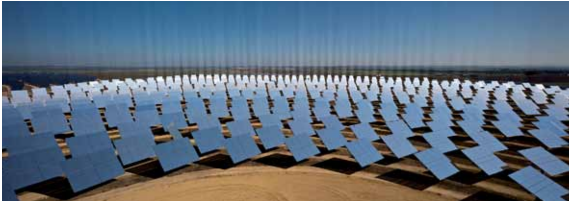
Izquierda y derecha Abengoa PS10. Primera torre solar termoeléctrica instalada en el mundo. Sanlúcar la Mayor. Sevilla.
