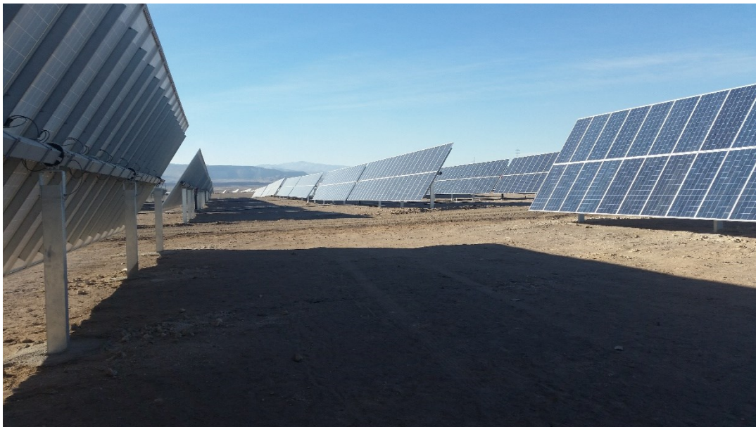
Figura 8. Seguidor de un eje horizontal. Vista detalle [Fuente: Archivo del Titular]
