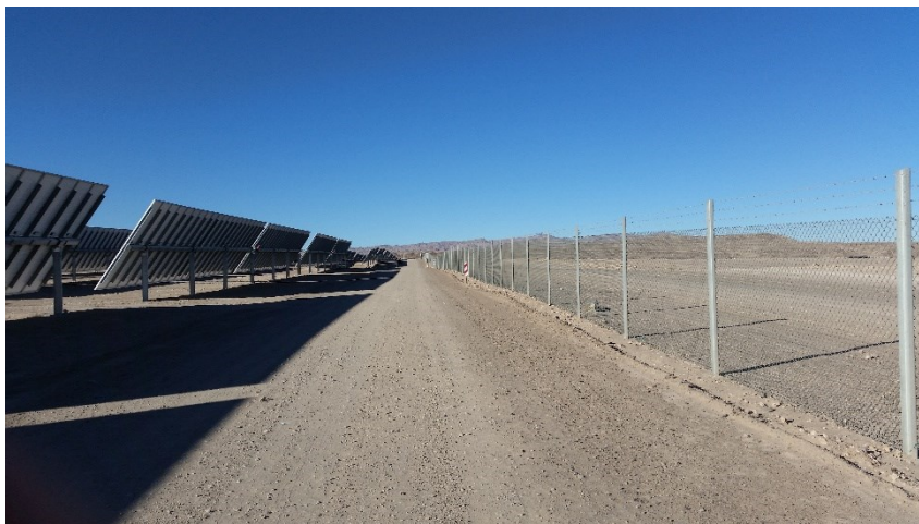
Figura 15. Cierre perimetral mediante malla de simple torsión coronada por 3 hileras de alambre de púas [Fuente: Archivo del Titular]
