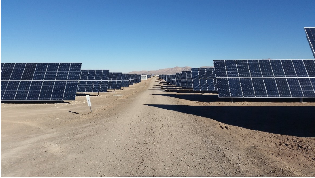
Figura 7. Seguidor de un eje horizontal. Vista general. [Fuente: Archivo del Titular]
