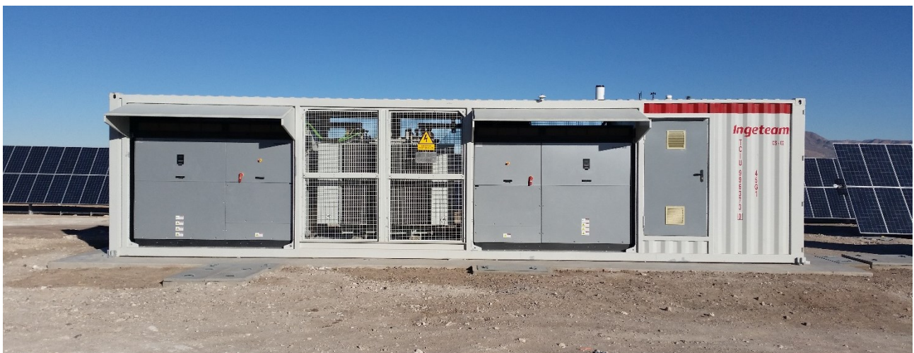
Figura 10. Sala Eléctrica tipo Outdoor. [Fuente: Archivo del Titular]
