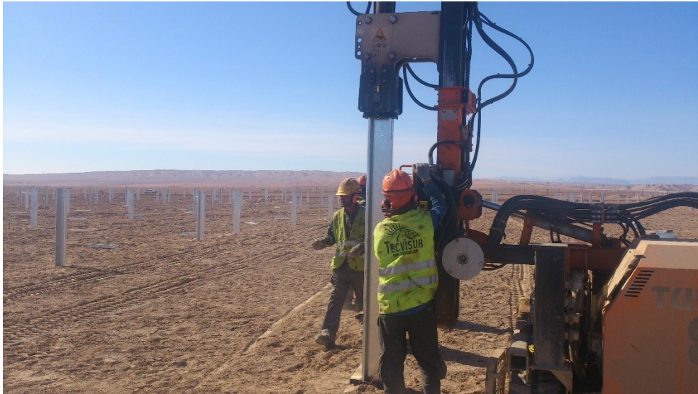
Figura 9. Cimentación pilotes tipo mediante proceso de hincado. [Fuente: Archivo del Titular]
