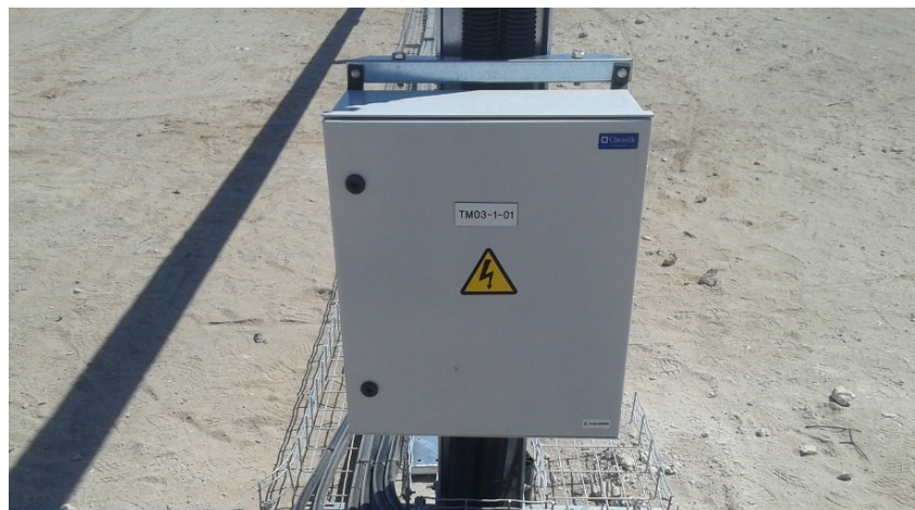
Figura 6. Cuadro eléctrico de protección de motores. [Fuente: Archivo del Titular]
