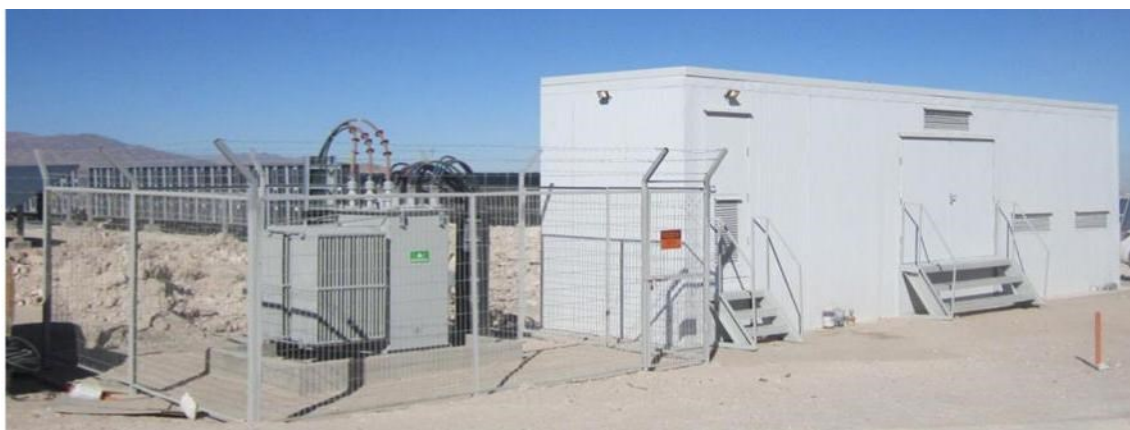
Figura 13. Transformador intemperie. [Fuente: Archivo del Titular]
