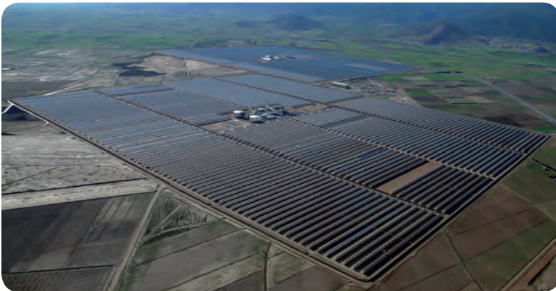
Varias centrales de Canal Parabólico ya funcionando en España.
